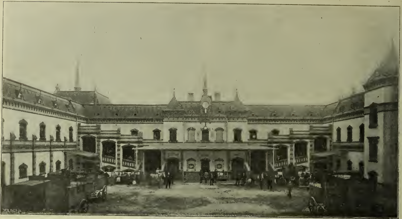
Ansicht des Hofes mit dem Blicke auf das Post-Stallgebäude.
